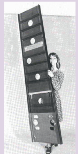
TIFF nr 1 1978. "På bilden visas hur lätt en stor flygplansdel i kompositmaterial är. Samma styrka hos kompositdelen som hos en aluminiumdel när man med bara halva vikten".
