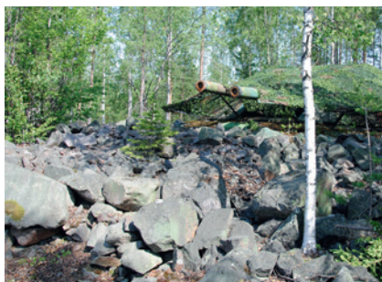
Exteriör bild av två kanoner. Ett av Siknäs batterierna med hela anläggningen i fyra plan insprängd i berget. Två av kanontornen finns kvar i dag.
