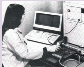
TIFF nr 1 1971, Materielverket hade införskaffat en Hewlett Packard DTS-70 som placerades vid FFV-U i Arboga för att användas vid test av digitala kretskort och autotestare, här har man troligen använt en bild från HP.
